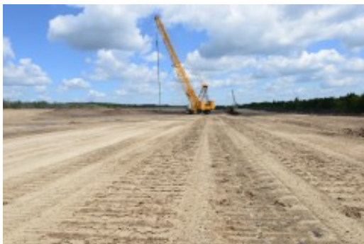
Bereits verdichteter Bereich
