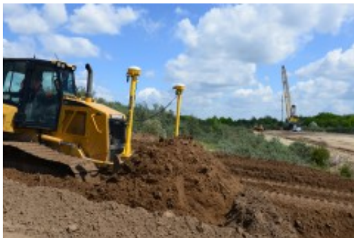
Profilieren der gesicherten Böschung
