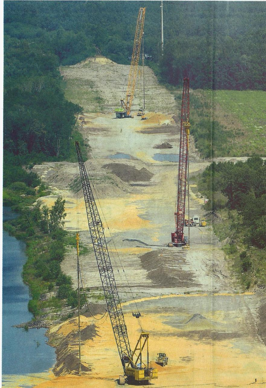
Der Bahndamm am Silbersee ist im Bereich der Innenkippe, also in Höhe des obersten Rüttelgerätes fertig saniert. Der Rest der Trasse soll 2014 fertig sein. Dann werden noch Tieflagen aufgefüllt, sodass nach derzeitigem Stand der Dinge die Deutsche Bahn hier ab 2016 mit dem Streckenneubau beginnen kann.
