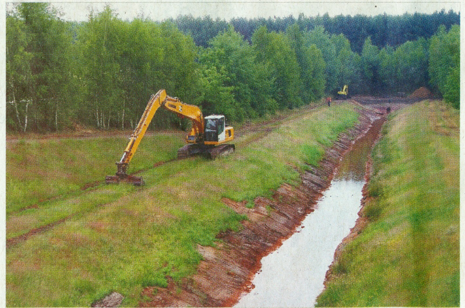
Westlich des Stadtrands, nördlich der Heine-Straße tritt das abgepumpte Grundwasser zu Tage. Der Westrandgraben leitet es ab. Jetzt, nach zwölf Jahren, wird er unter anderem neu profiliert. Im Spätherbst soll alles fertig sein.
