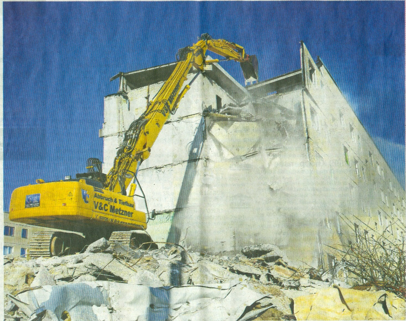
Da stand noch ein Teil des Blocks. Doch bereits Freitagmittag hatten die Mitarbeiter der Firma V&C Metzner aus Wittichenau den Block Kastanienring 10 bis 16 in Königswartha abgerissen. Der Schutt wird bis Ende November beräumt.
