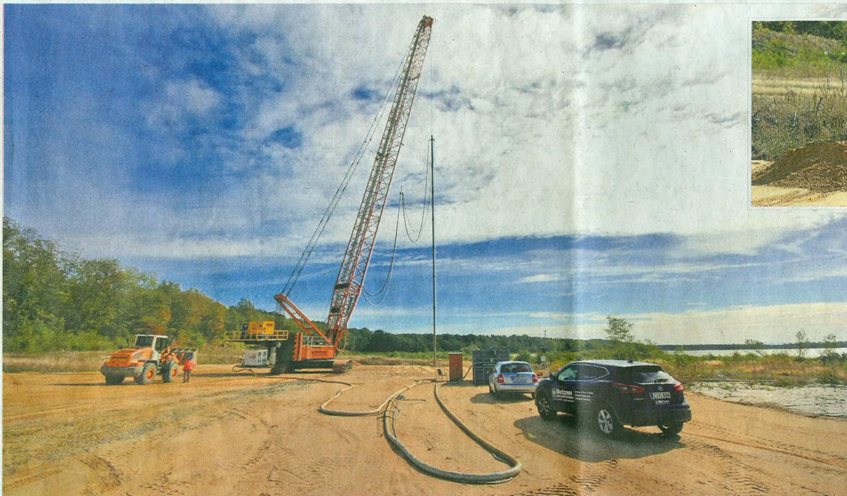
Am Nordufer des Knappensees schafft der Rütteldruckverdichter Stück für Stück einen unterirdischen Damm. Das kleine Bild zeigt die Spitze der Rüttellanze.
