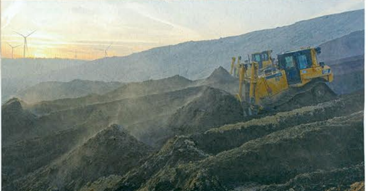
Eine Cat Raupen vom Typ D8T baut am Tag bis zu 30 000 Kubikmeter Material ein. Foto: Manfred Hoffmann
