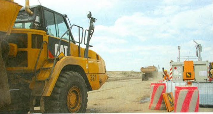
Innerhalb von einer Stunde muss die Dumperflotte über vier Zapfsäulen betankt werden.
