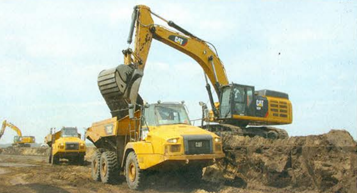
Beladen werden die Dumper von großen Kettenbaggern, wie den Cat 374FL, Cat 374DL, 352F und 349EL.
