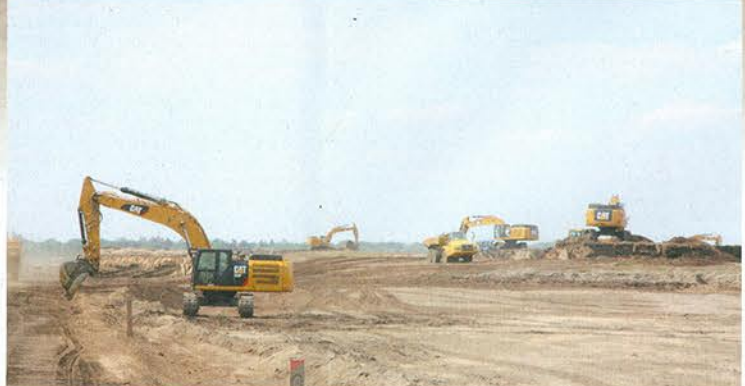
Jeder Lade- und Kippstelle wurden Dumper zugeordnet.
