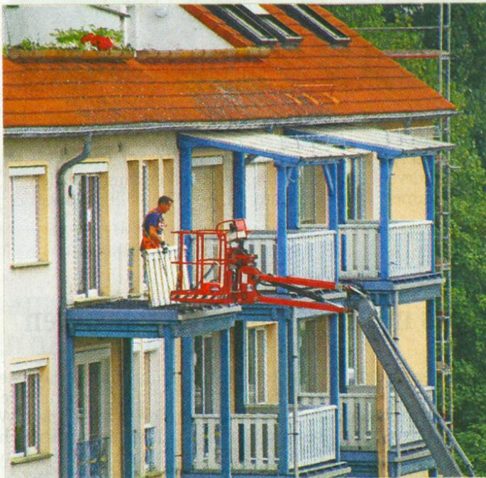
Vor ein paar Tagen begann die Demontage der Balkone. Inzwischen ist sie beendet. Nach erfolgter Fassaden-Sanierung wird im September Ersatz angebaut – statt aus Holz aus Aluminium.
