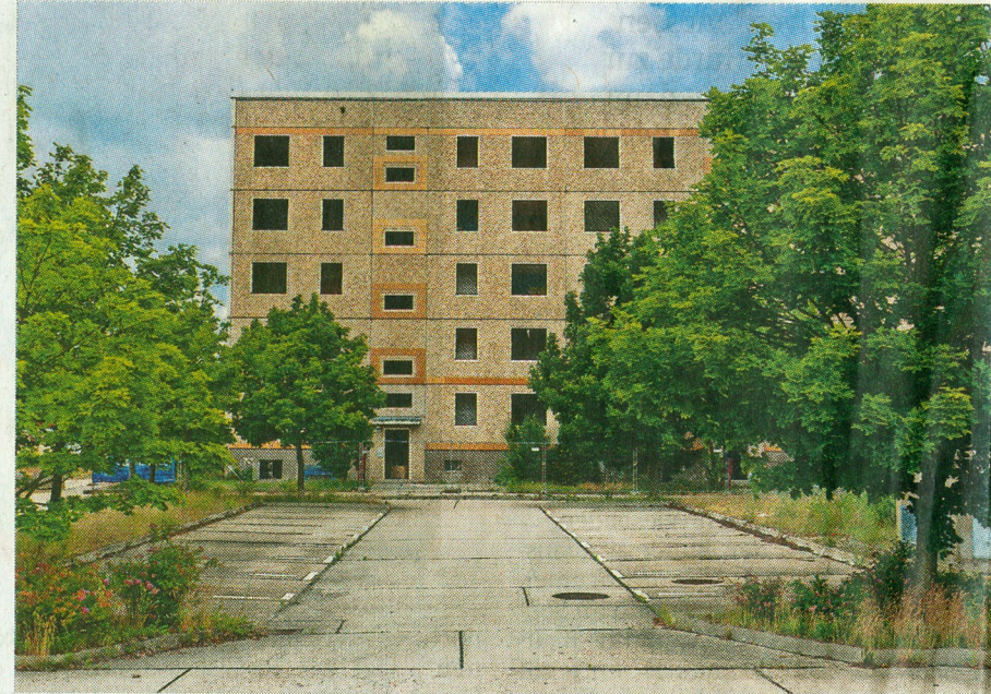
In wenigen Wochen ist dieser Block in der Dürer-Straße abgerissen. Denkbar sind hier künftig Eigenheime.
