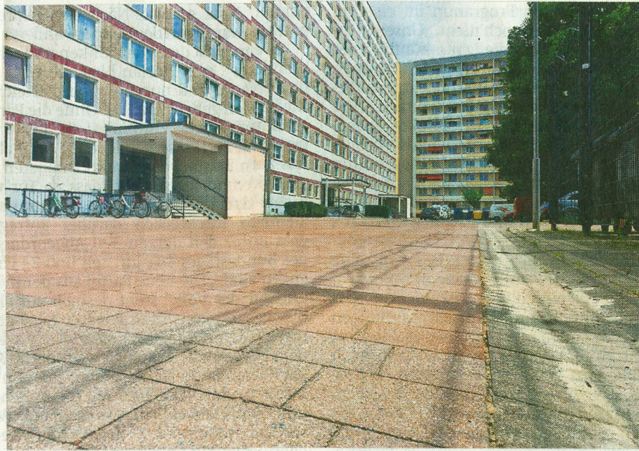
Rötlich schimmern die neuen Gehwegplatten in der Albert-Schweitzer-Straße im Bereich der Aufgänge 24-26. Das sollte jetzt wieder ein paar Jahre halten.
